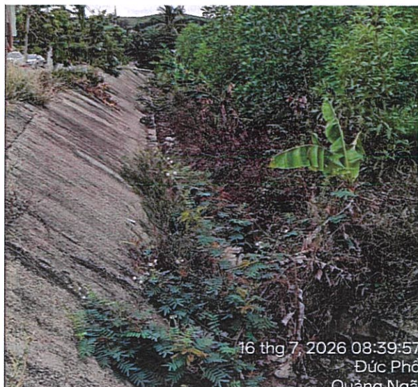
Mương BT cấp nước
