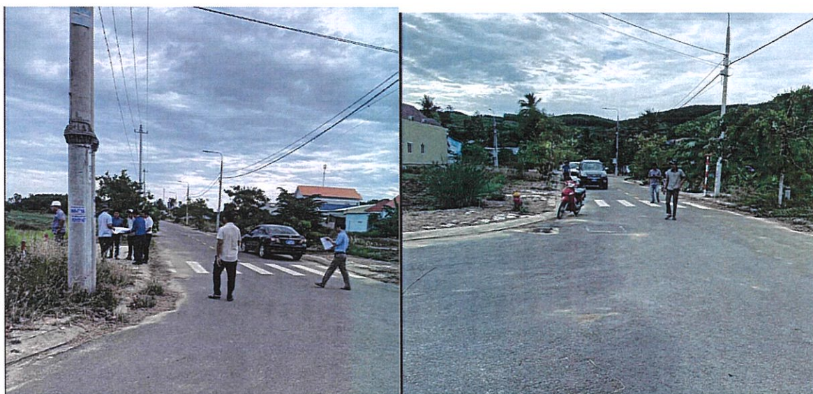
Hình 4. Hiện trạng nhà ở khu TĐC Đồng Hóc hiện hữu
