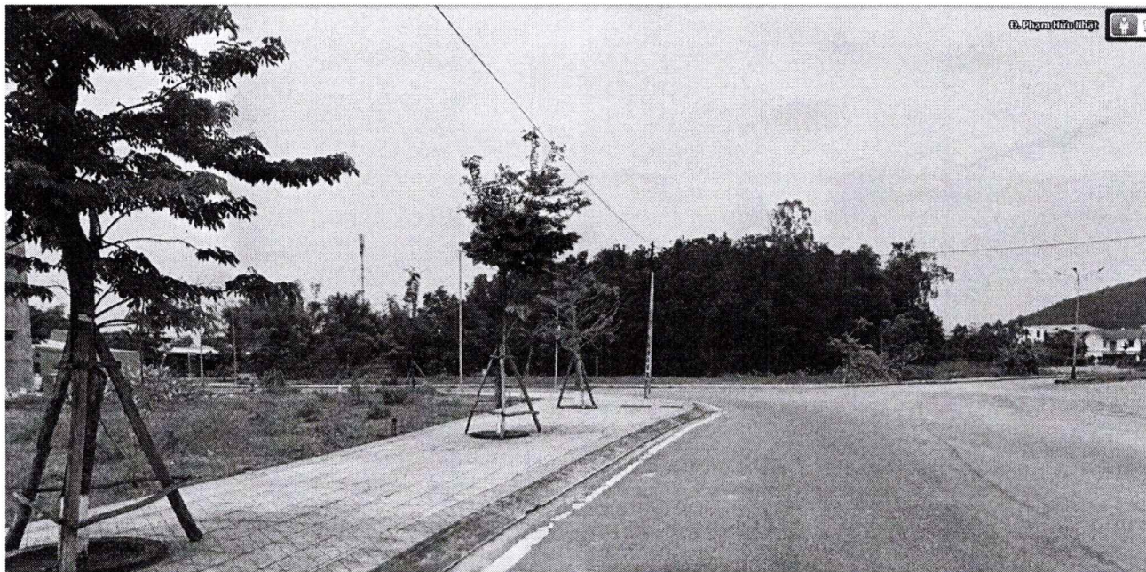
Hiện trạng khu vực lập điều chỉnh cục bộ
